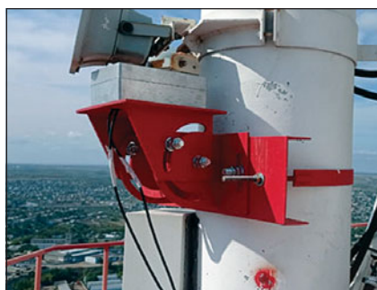
Рис. 3. Размещение блока измерения ZETLAB 7154 на конструкции башни
